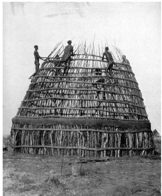
Abbildung 4: Bau eines Kuhstalls
